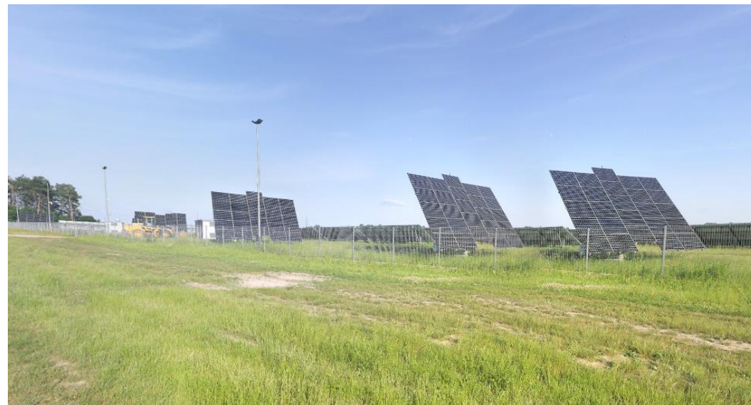
Zdjęcie 2. Farma fotowoltaiczna BC i SIS Włodawa w miejscowości Korolówka-Kolonia
