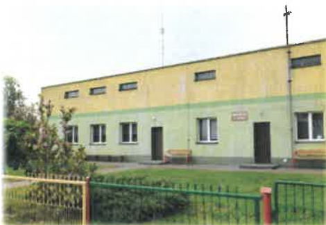
Świetlico - remiza w Krasówce
